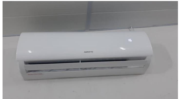
SALA MULTIUSO 01 - AR CONDICIONADO AGRATO 18.000 BTUS
